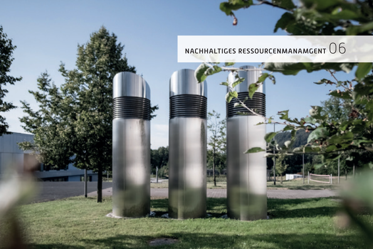
Erdkollektoren vor dem Zentralen Neubau
