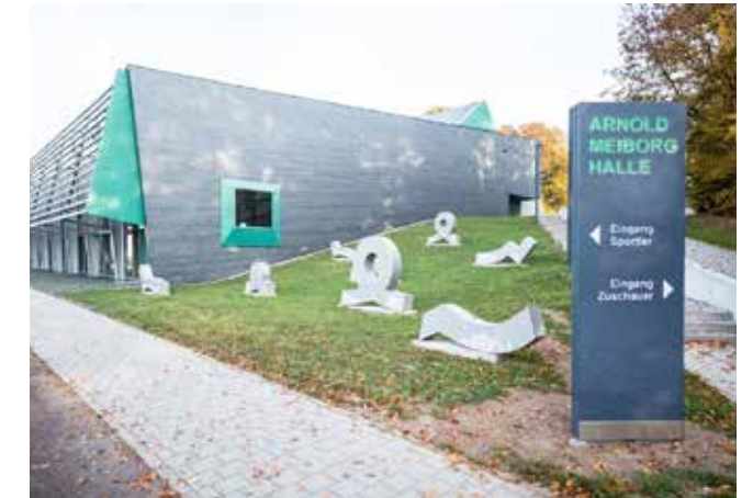
Die „Arnold Meiborg Halle“ wird einerseits als Sporthalle und andererseits als Praxislabor für Studienzwecke genutzt
