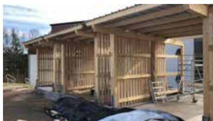
Umbauarbeiten am neuen Wertstoffsammelplatz
