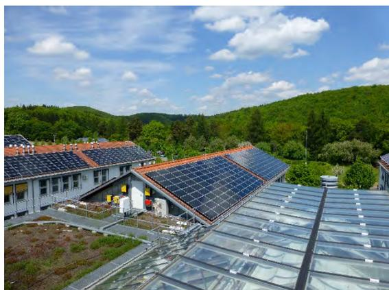
Dächer überwiegend mit Photovoltaik und Solarkollektoren bestückt, links extensive Dachbegrünung
