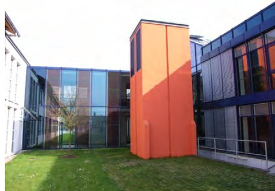
Adsorptions-Kühlturm mit Wärmerückgewinnung an der Südseite der Hörsäle
