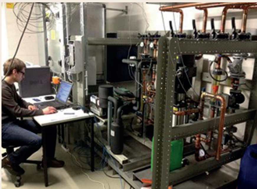
Bild 14: Messungen eines KVS mit Einbindung der Wärmepumpe. Foto: Howatherm
