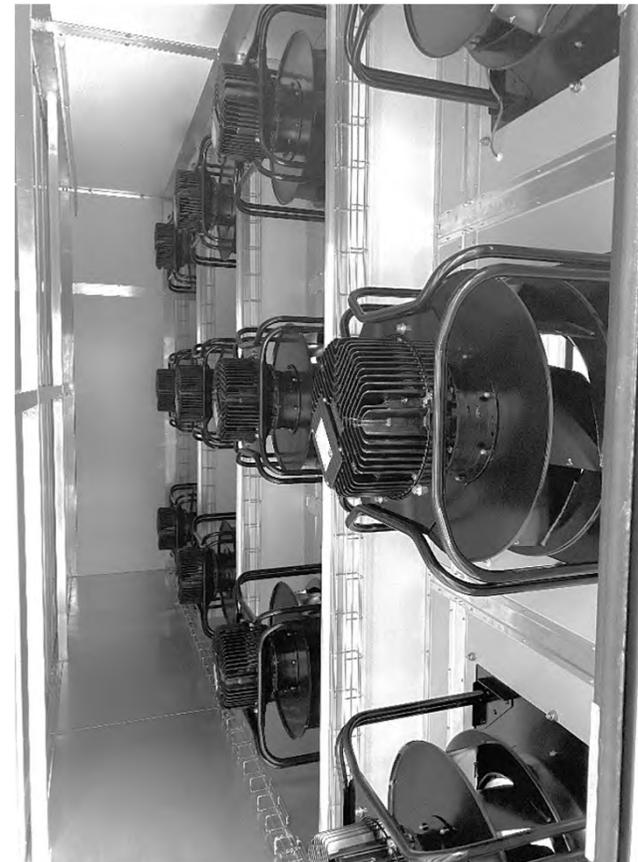
Radialventilator mit EC-Motor (Kompletteinheit)
