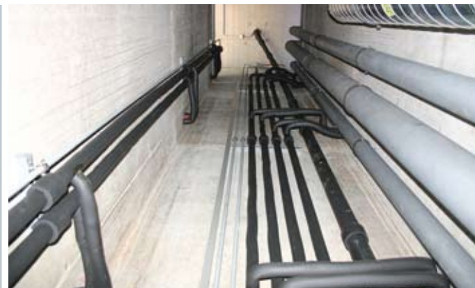
Bild 12: Fortluftkanal als Massivabsorber
