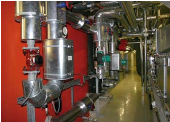
Bild 12: Warmwasserspeicher der Solaranlage
