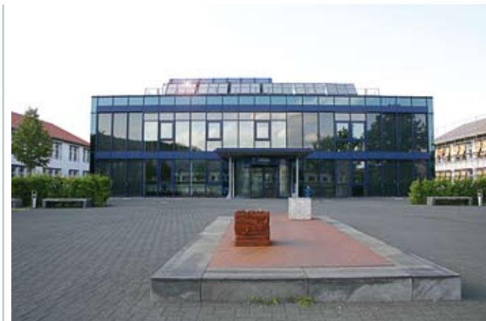
Bild 2: Der Zentrale Neubau mit Solarthermie-Anlage
