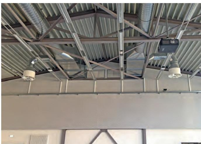
27 Anwendung des CrossXchange-Verfahrens zur intermittierenden und instationären Raumlüftung in einem Hörsaal der Fachhochschule Soest.
