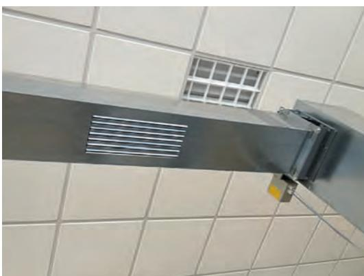
15 Zuluftgitter mit Strangregelklappe des Versuchsaufbaus.
