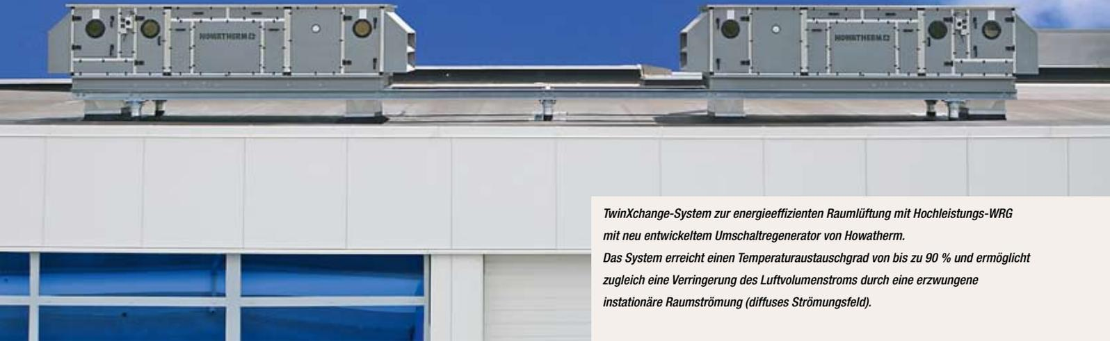
*TwinXchange-System zur energieeffizienten Raumlüftung mit Hochleistungs-WRG mit neu entwickeltem Umschaltregenerator von Howatherm.*
